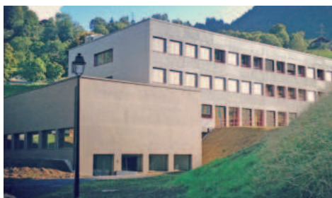
Collège d'Aigremont - Le Sépey Ossature bois et dalle mixte - 2014/2015
